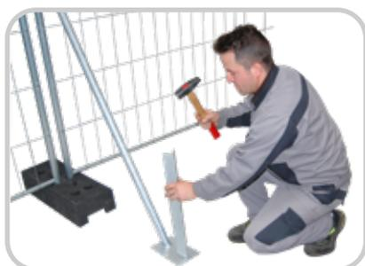
Alternativ: Befestigung der Bodenplatte mittels Dübel im Boden oder mittels Erdspiess/Erdnagel in der Erde.
