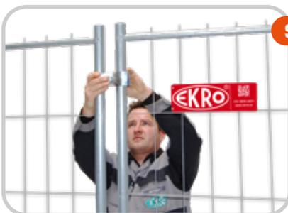
Im oberen Elementbereich die Mobilzaunelemente mithilfe der Bauzaunklemme verbinden und die Klemme mit einem Schlüssel festziehen.
