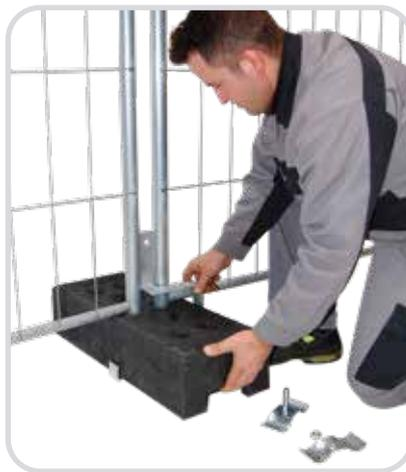
**Schritt 2:** Mit Hilfe der Bauzaunklemme die Aushebesicherung mit den Zaunelementen verbinden.
